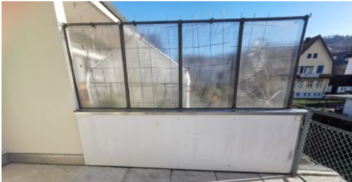
11 Malergeschäft mario Vassanelli 024 Terrasse Fassade streichen
